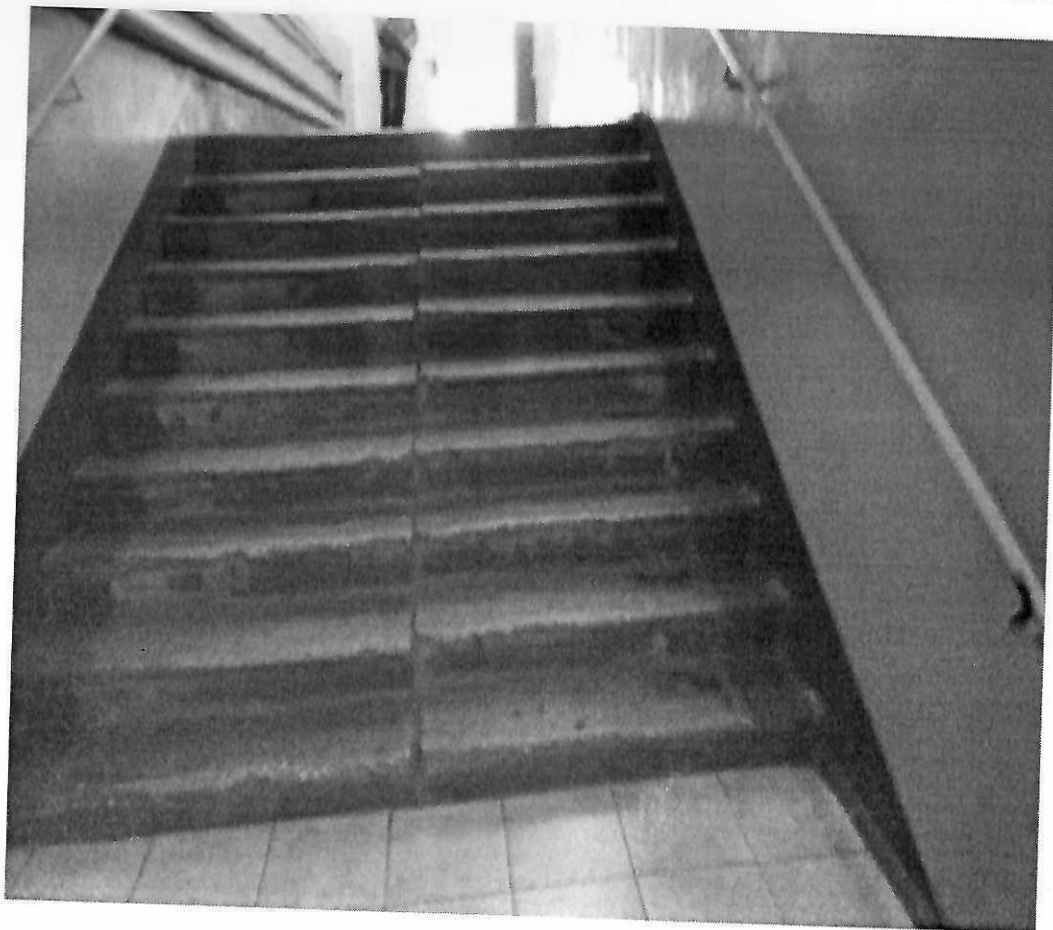
Лестница (внутри здания) – Фото №21
