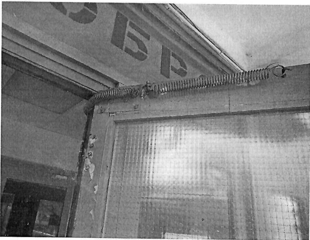
Дверь (входная) – Фото №14
