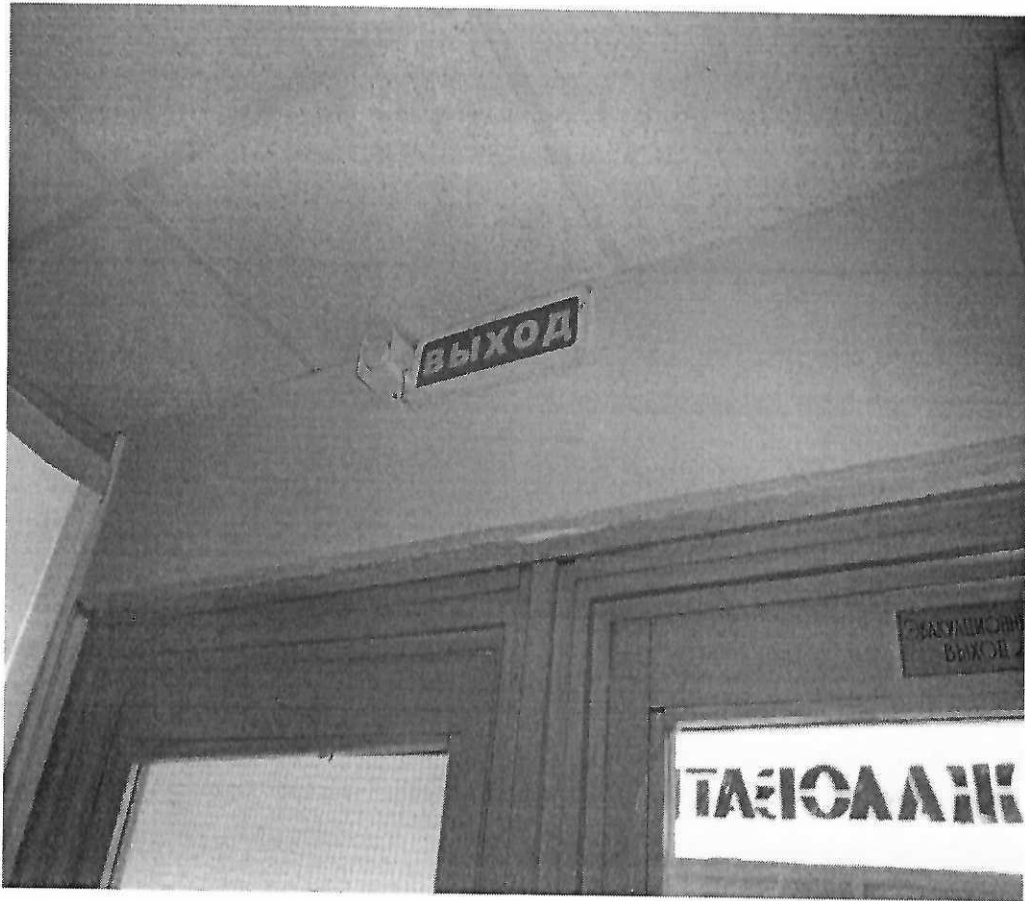
Пути эвакуации – Фото №37
