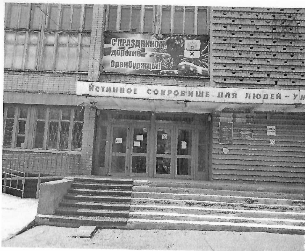
Входная площадка (перед дверью) – Фото №11
