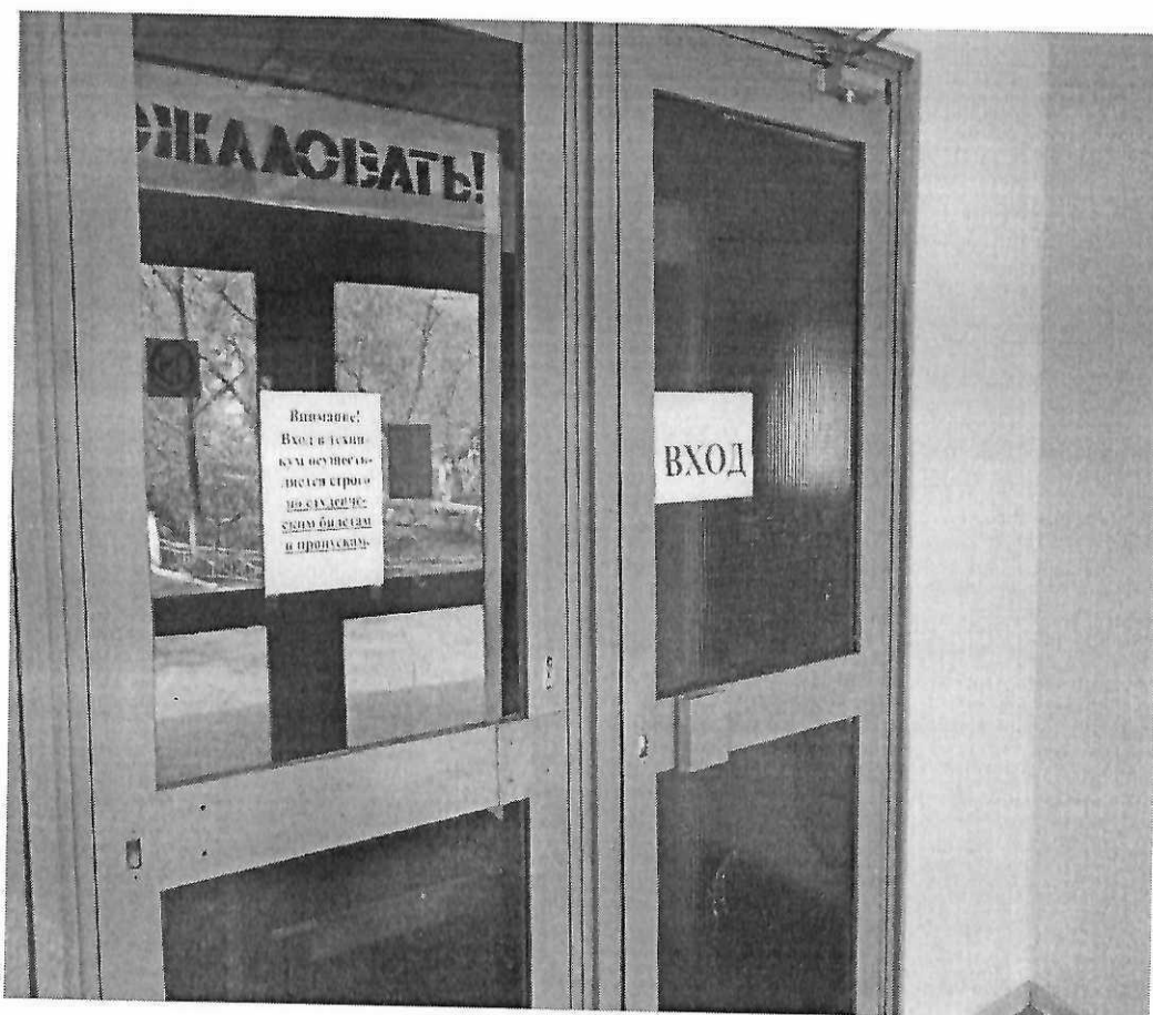
Дверь (из тамбура в вестибюль) – Фото №25
