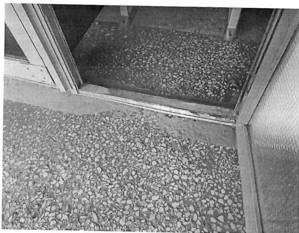
Дверь (из тамбура в вестибюль) – Фото №26
