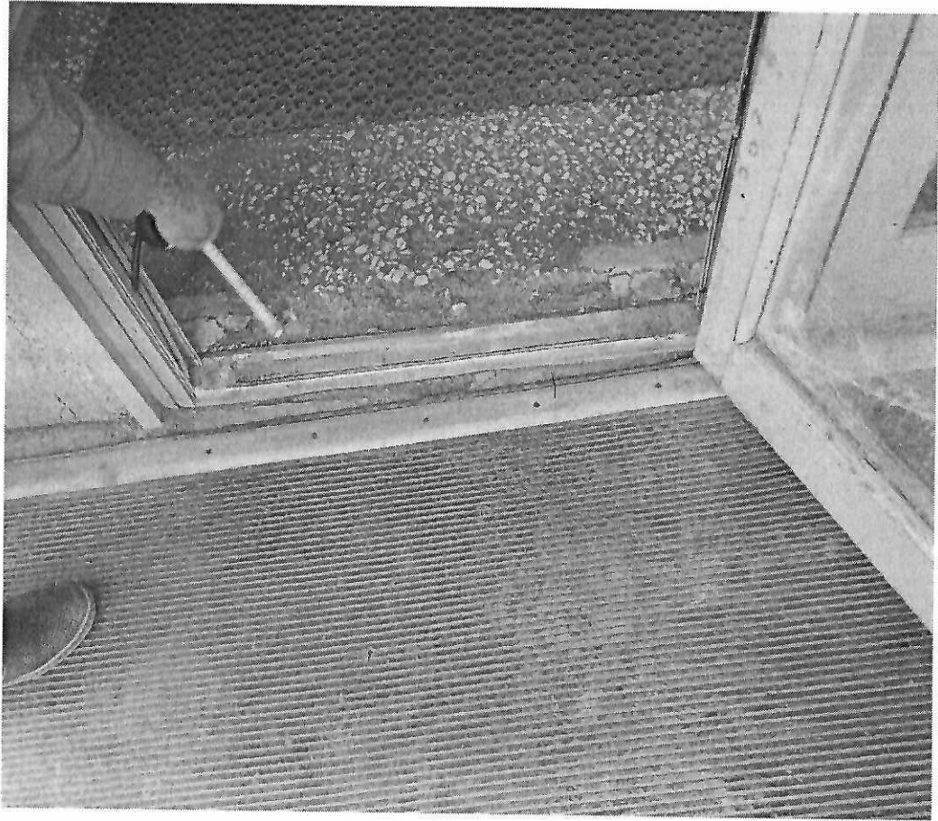
Дверь (входная) – Фото №13
