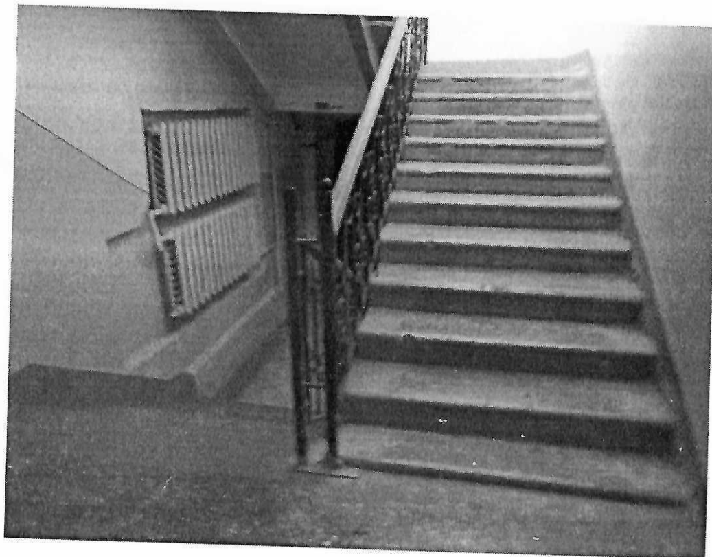
Лестница (внутри здания) – Фото №22
