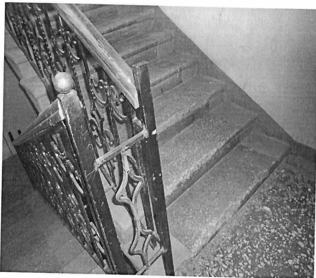
Лестница (внутри здания) – Фото №23
