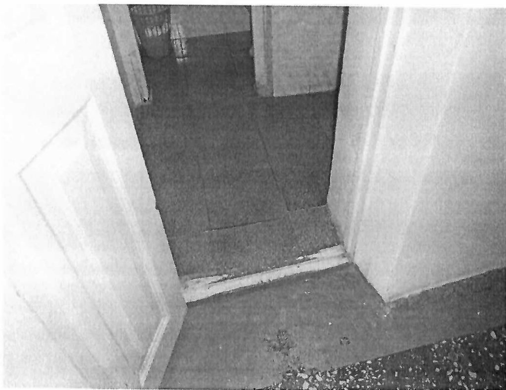
Дверь (в туалетную комнату на 1-м этаже) – Фото №52
