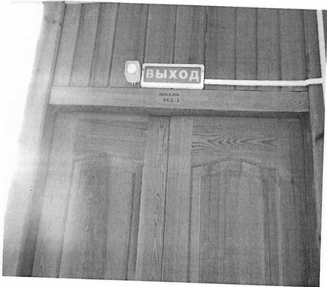
Пути эвакуации – Фото №39
