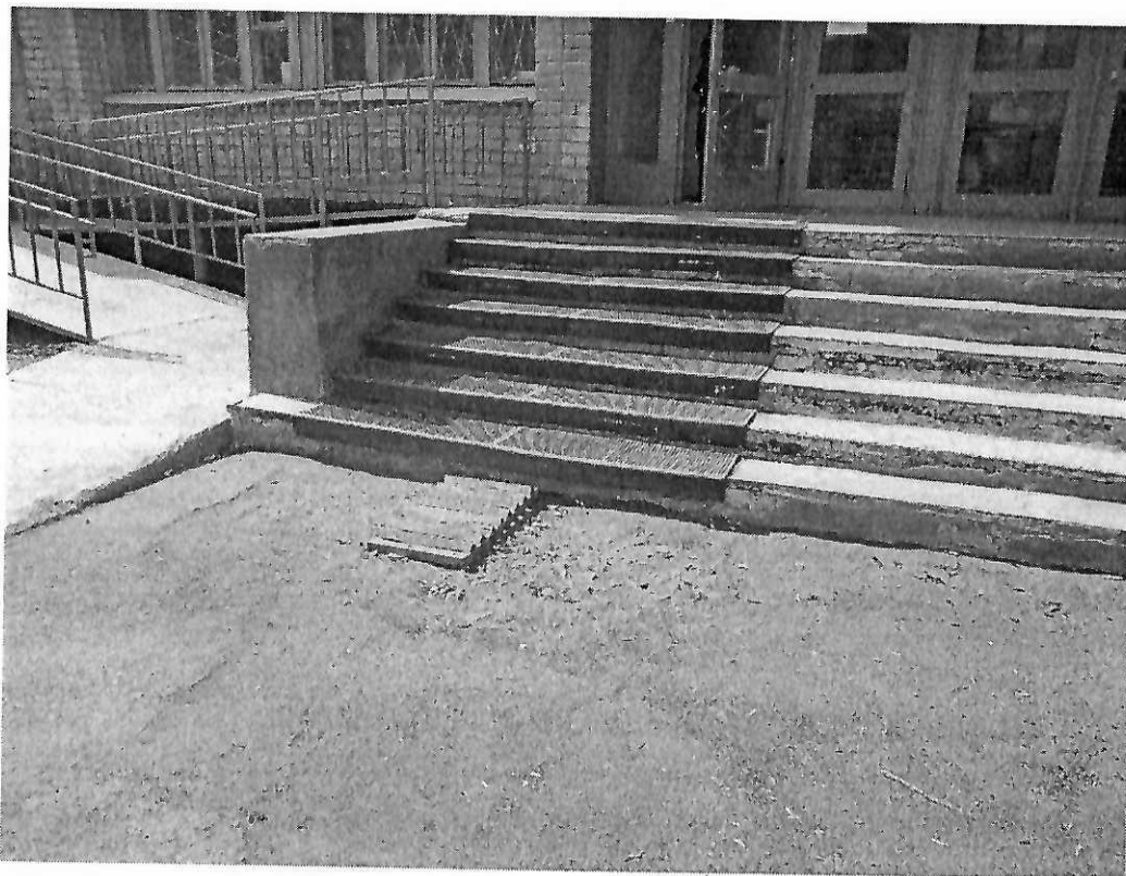
Лестница (наружная) – Фото №6
