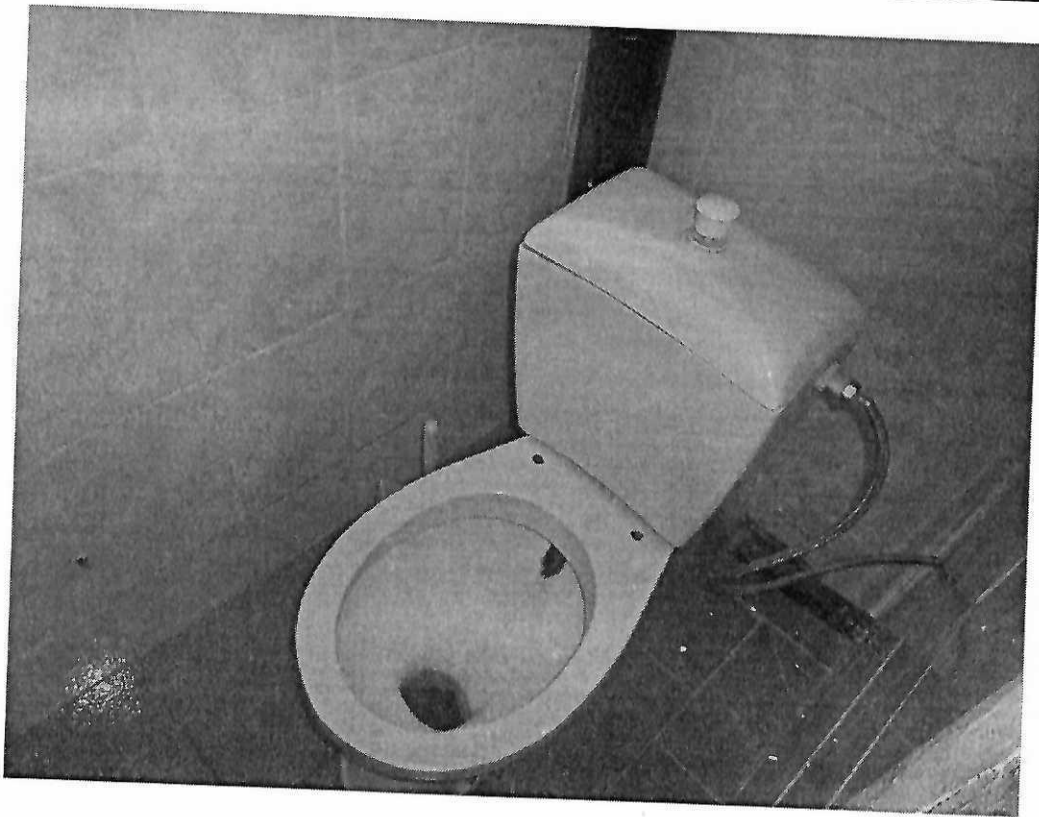
Туалетная комната (на 1-м этаже) – Фото №54
