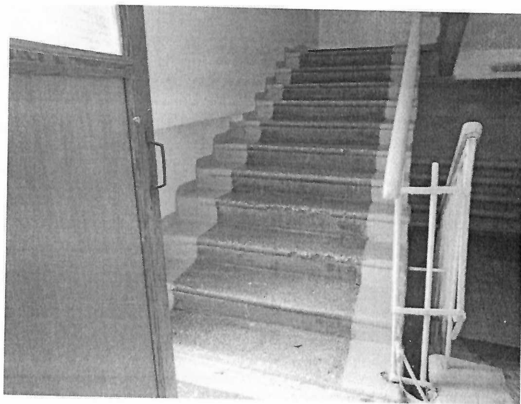
Лестница (внутри здания) – Фото №24
